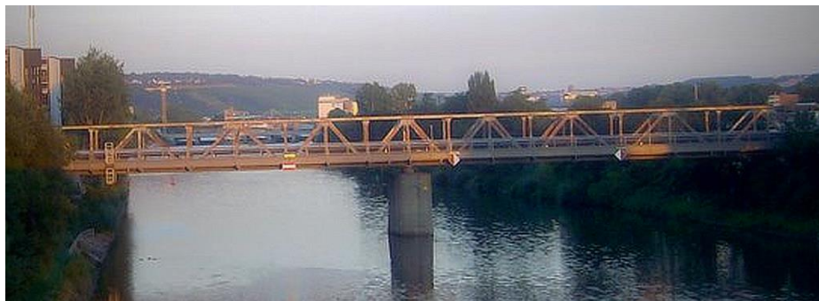
Abbildung 2: Stahlbrücke bei km 185,2 (Daimlerwerk)
